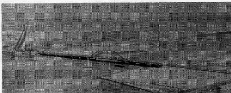
アブダビから内陸に通ずる橋
