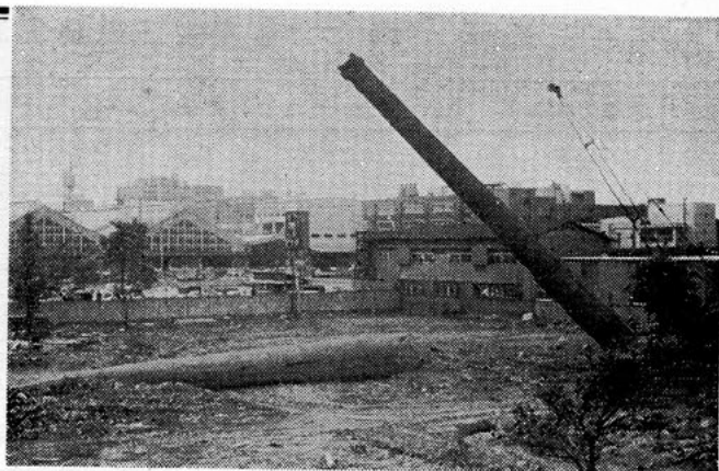
水路部旧庁舎名残りの大煙突撤去作業
