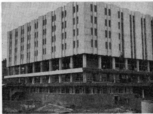
工事中の海洋学研究所の新しい建物
