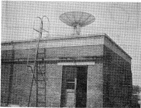
写真1 衛星の受信アンテナ
