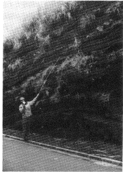
写真2 波浮地区の道路の切割り
