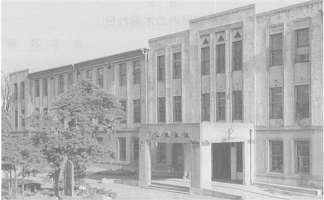
写真2 旧水路部庁舎
