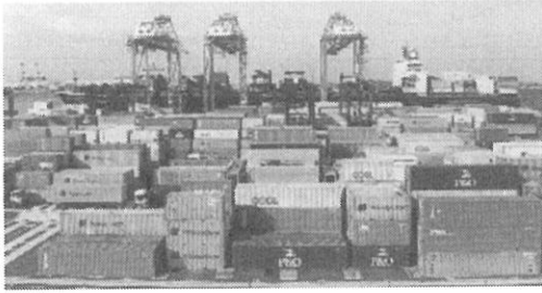
図3 規格化された 40feet コンテナと 20feet コンテナ(コンテナの規格や強度は ISO で規格化)
