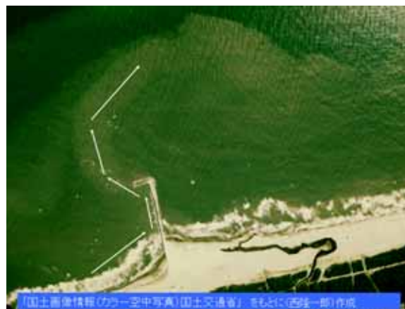
図16 港湾構造物に沿う離岸流
