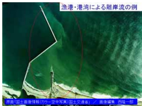
図14 港湾構造物に沿う離岸流
