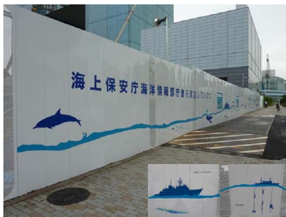
工事現場の仮囲い
