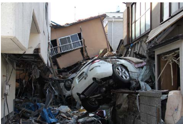
写真3 釜石市内の民家周辺の被災状況で漂流してきた車両が民家に突き刺さっている
