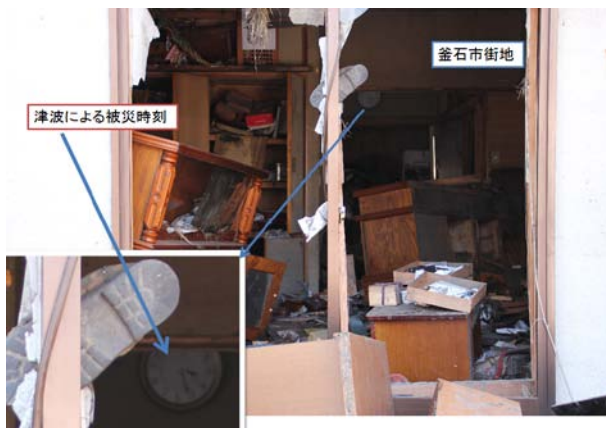
写真2 釜石市内の住宅の被災状況例 (時計が3時26分で止まっている)
