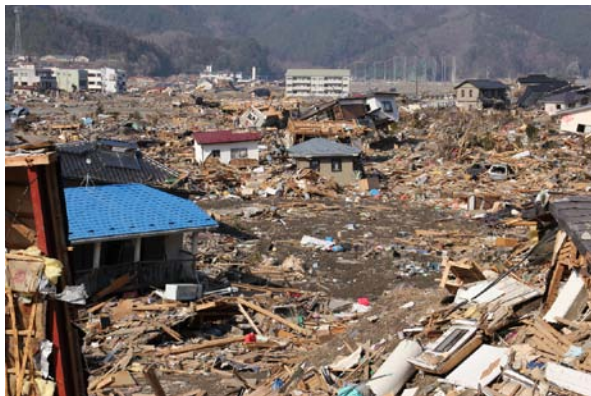
写真7 大槌町（大槌湾）の被災状況 （写真奥が湾口側）
