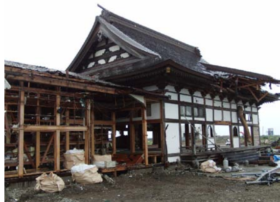
写真15 名取市閑上東禅寺の被災状況
