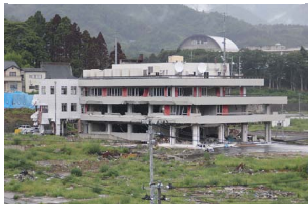
写真11 女川町役場付近の被災状況
