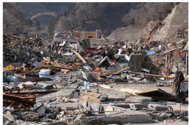
写真6 両石地区（両石湾）の被災状況で、堤防を越えて遡上した津波により沢状地形に沿って被災が生じている
