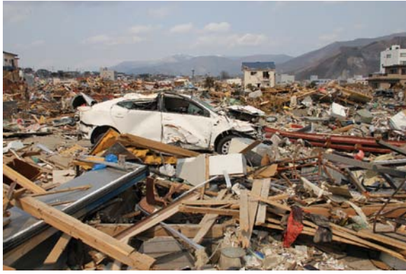
写真 12 大船渡市街地の被災状況 2
