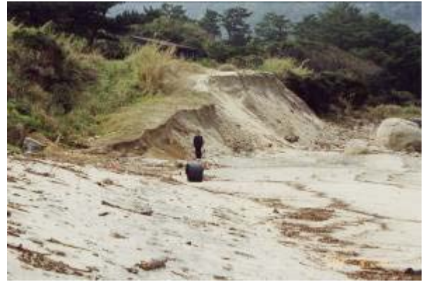
写真3 貯留式養浜の様子
