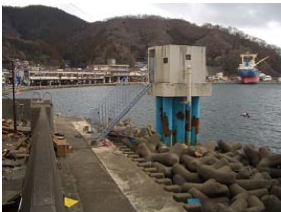
東日本大震災直後の釜石験潮所
