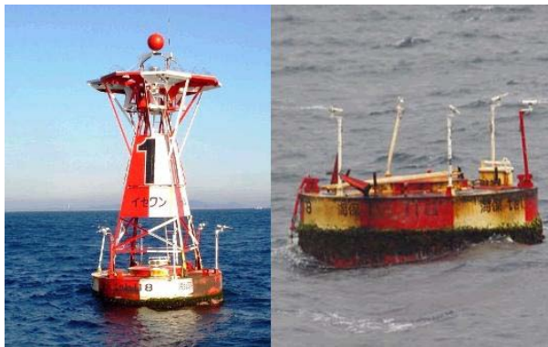
伊勢湾1号灯浮標(右が脱落後の写真)
