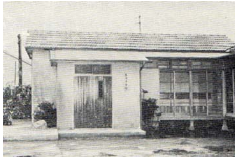
写真8 昭和28年に建設された「五海洋会館」
