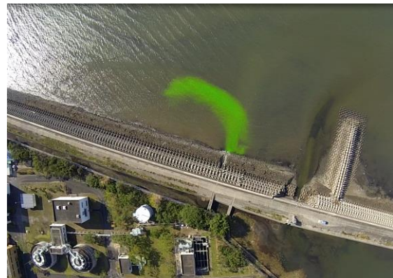
写真6 放流水の移流拡散の可視化
