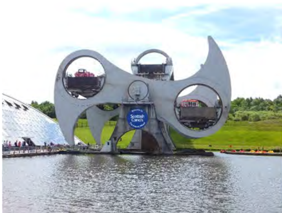
写真5 昇降中のゴンドラ
