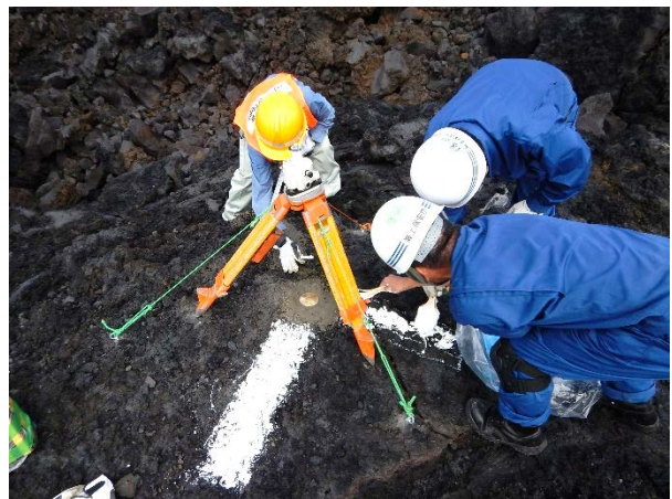
写真11 2016年10月28日新島での三角点設置作業 (国土地理院撮影)
