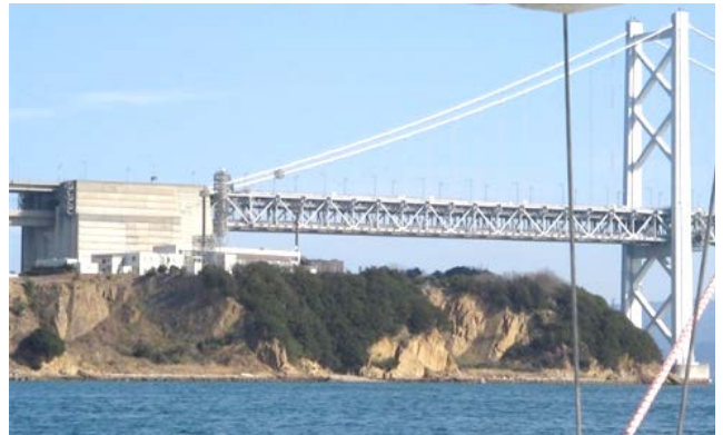
写真8 備讃瀬戸海上交通センターのレーダー設備
