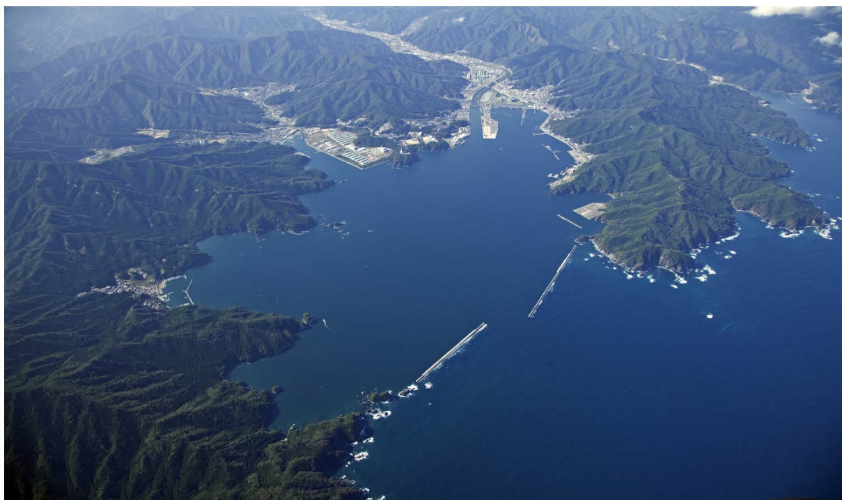
写真6 釜石港湾口防波堤
