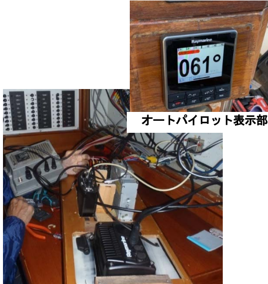
配電盤にAIS・GPS、古野GPS魚探設置
