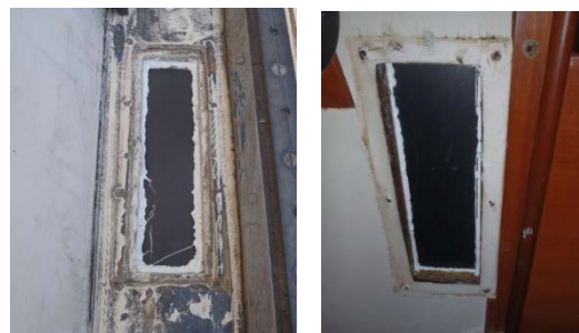
外側からゴム板を張る 内側からゴム板を張る
