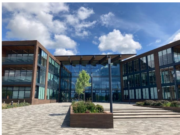
写真① UKHO の庁舎
