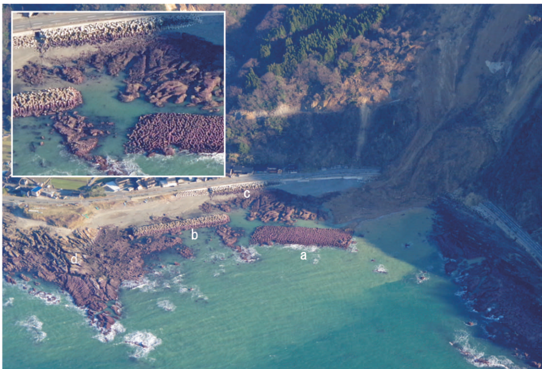
図 3 珠洲市真浦町地区の地盤隆起と土砂崩壊
